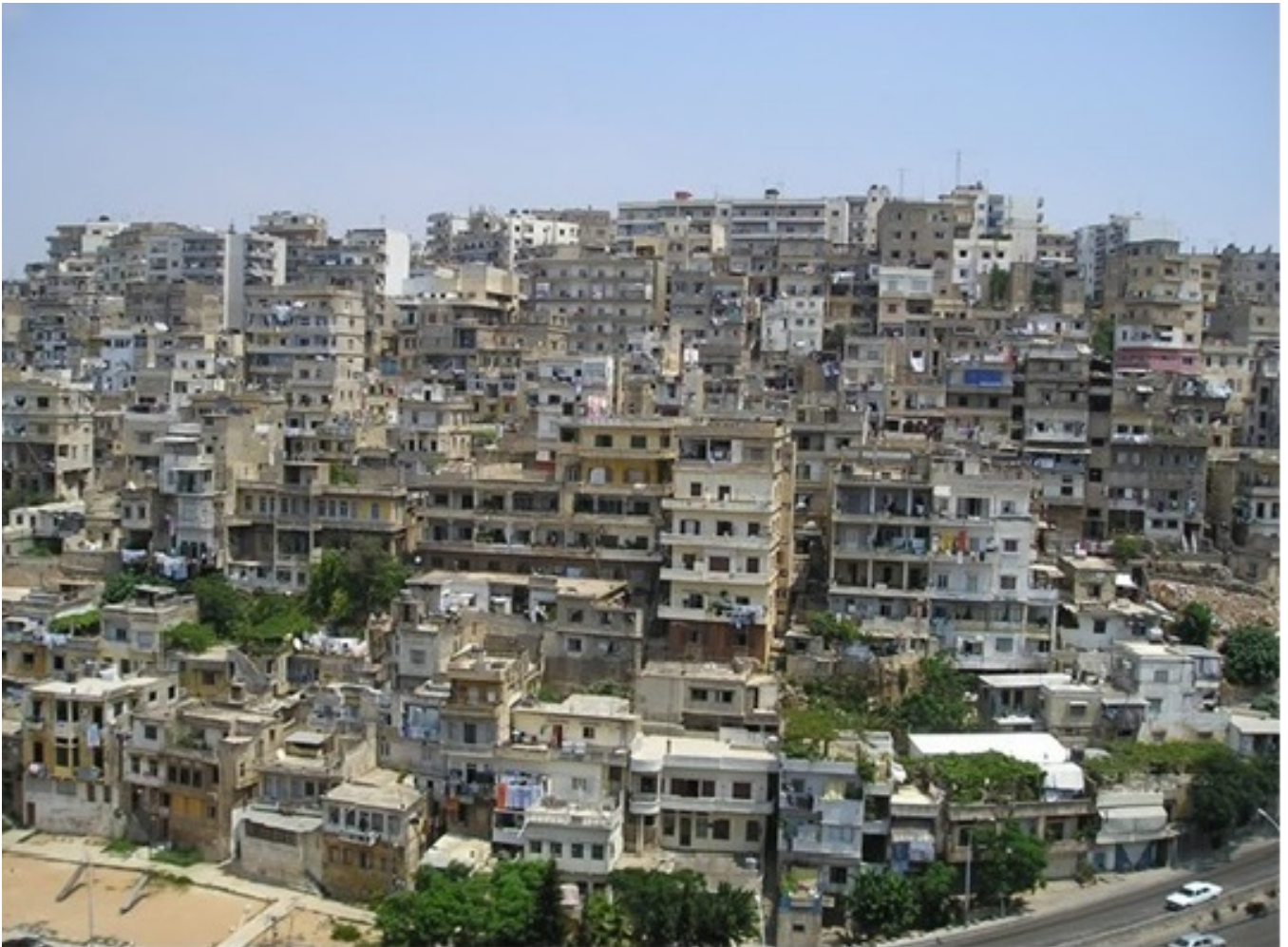
Figure 5: vue générale de l'ensemble du quartier Tebbeneh et les immeubles interposés entre Baal Mohsen/Tebbaneh
